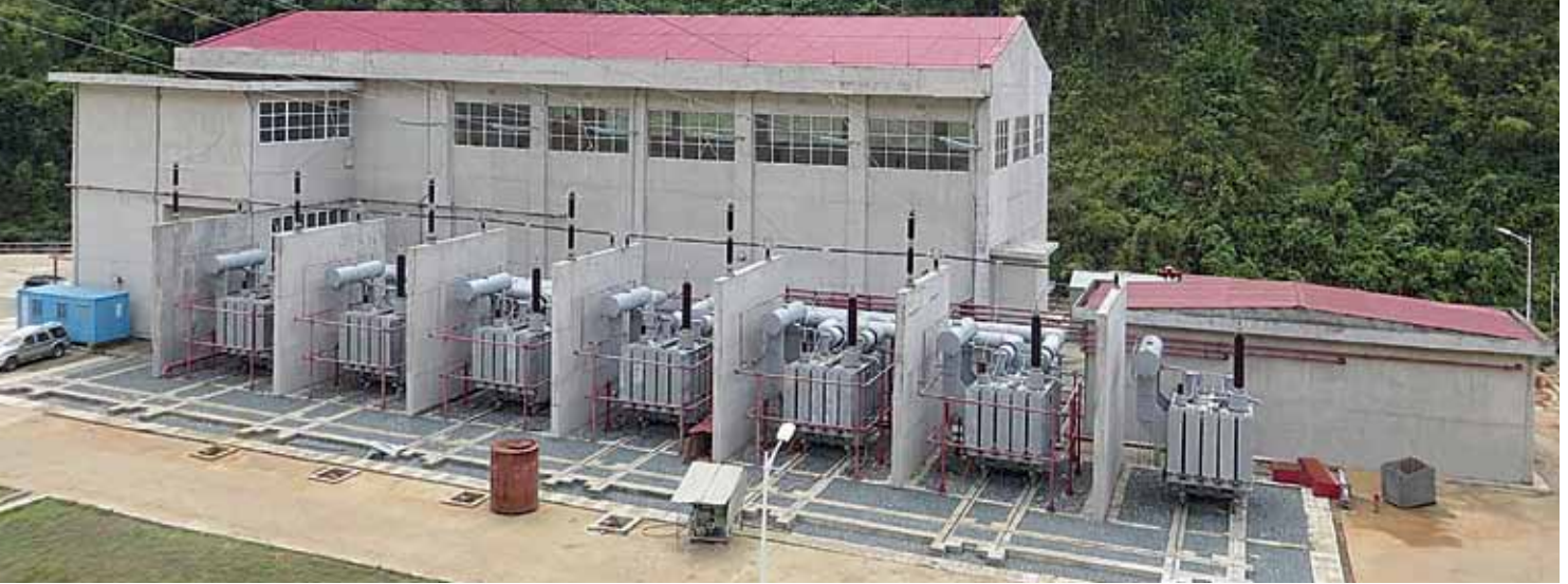
▲ Central Hidroeléctrica Xekaman 3
