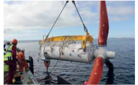
▲ Instalación en el sitio de EMEC
