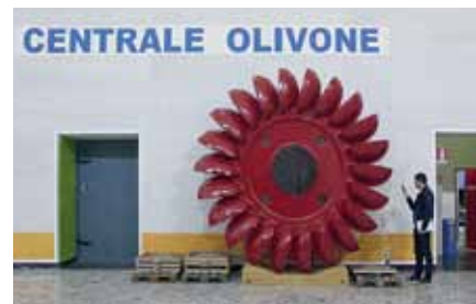
▲ Central Hidroeléctrica Olivone
