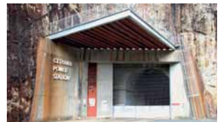
▲ Entrada del túnel hacia la caverna de CH Cethana
