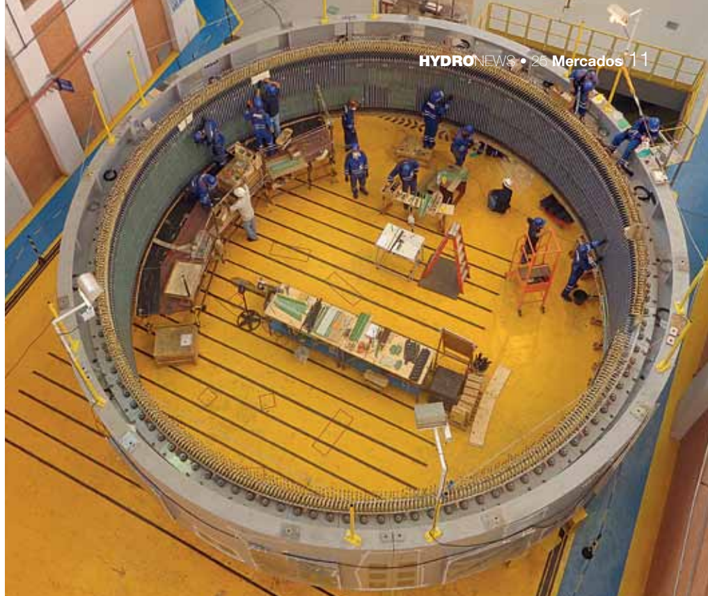
▲ Ensamblado del bobinado en la CH Cachoeira Dourada
