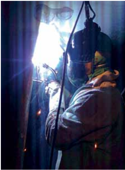
▲ Servicios de reparación de cavitación en la CH Taquaruçu
