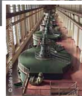
▲ Casa de máquinas
